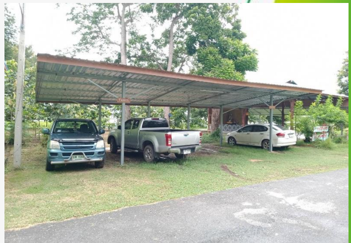
ที่จอดรถบุคลากร(CAR PARK) สร้างเอง ปีที่สร้าง 2564
