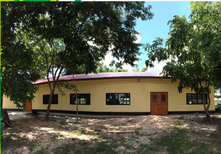
อาคารหอประชุม แบบ ป.๑ ฉ ปีที่สร้าง 2520
