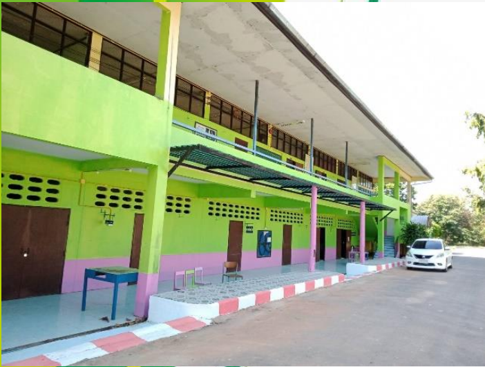
อาคารเรียน สปช.105/29 ปีที่สร้าง 2528
